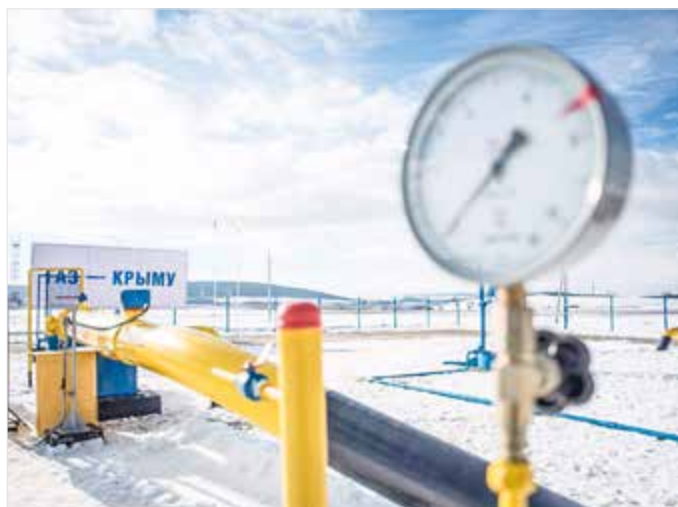
27 декабря. Газопровод Краснодарский край – Крым © www.glava.rk.gov.ru
