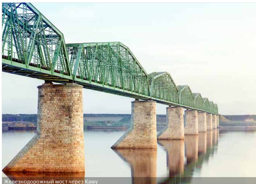
Железнодорожный мост через Каму
