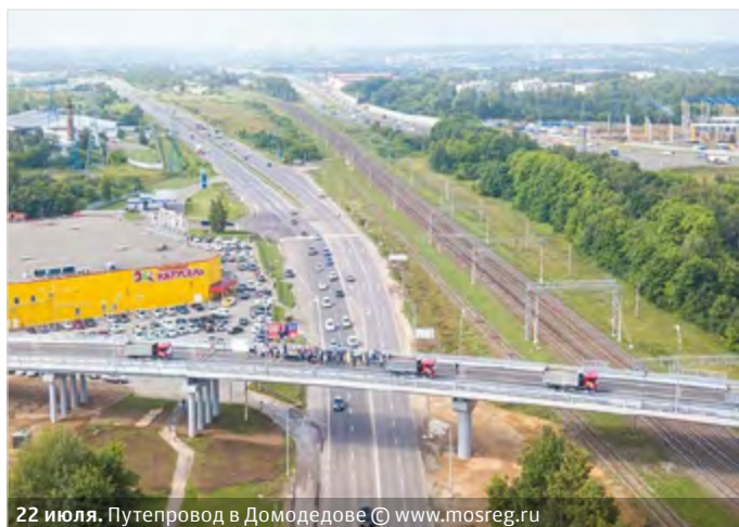
22 июля. Путепровод в Домодедове © www.mosreg.ru
