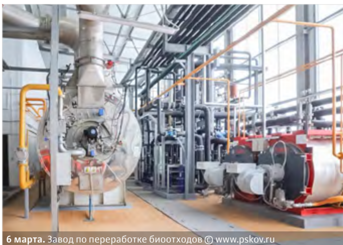
6 марта. Завод по переработке биоотходов © www.pskov.ru
