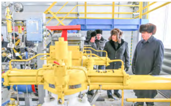
18 декабря. Газопровод «Миннибаево – Казань» © www.tatarstan.ru
