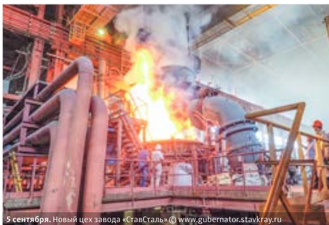
5 сентября. Новый цех завода «СтавСталь» © www.gubernator.stavkrai.ru
