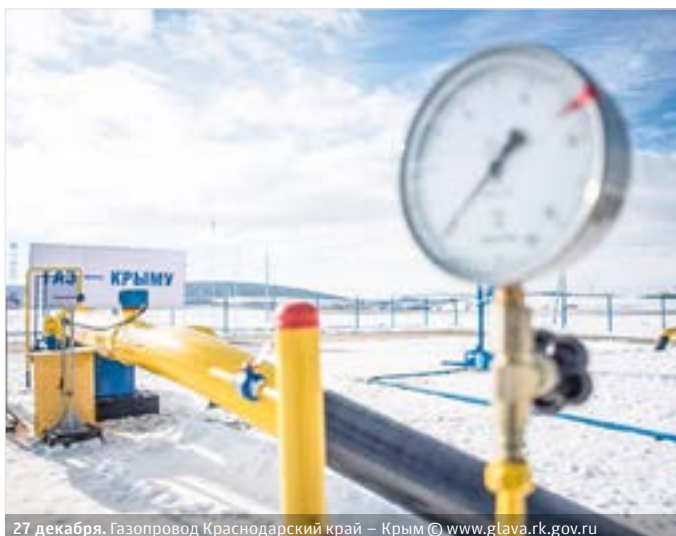
27 декабря. Газопровод Краснодарский край – Крым © www.glava.rk.gov.ru
