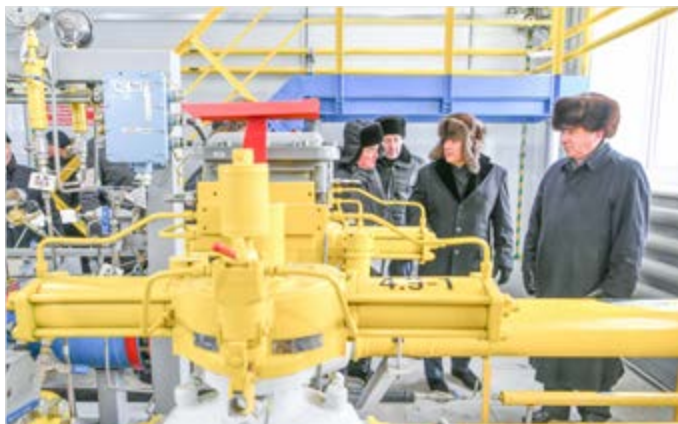
18 декабря. Газопровод «Миннибаево – Казань» © www.tatarstan.ru
