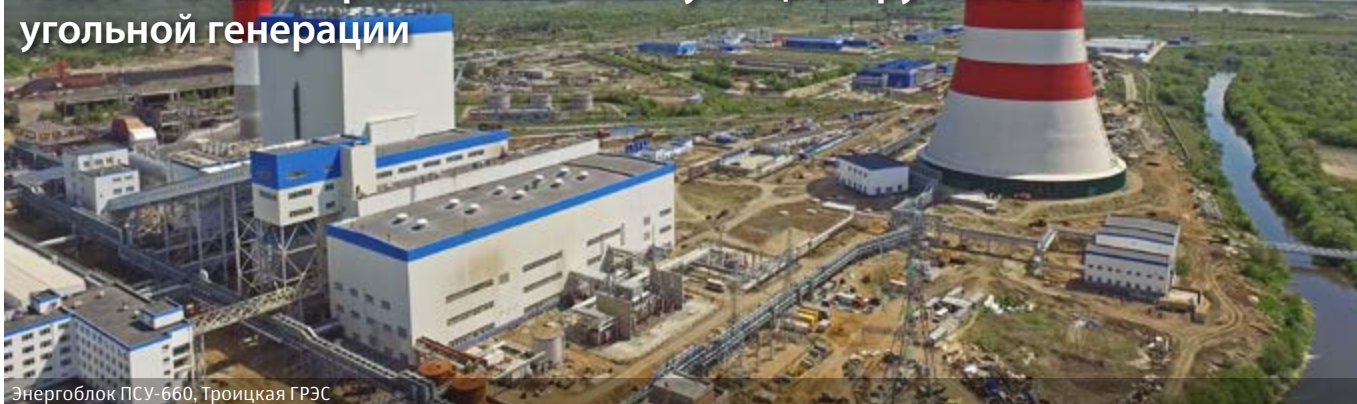
Энергоблок ПСУ-660, Троицкая ГРЭС
