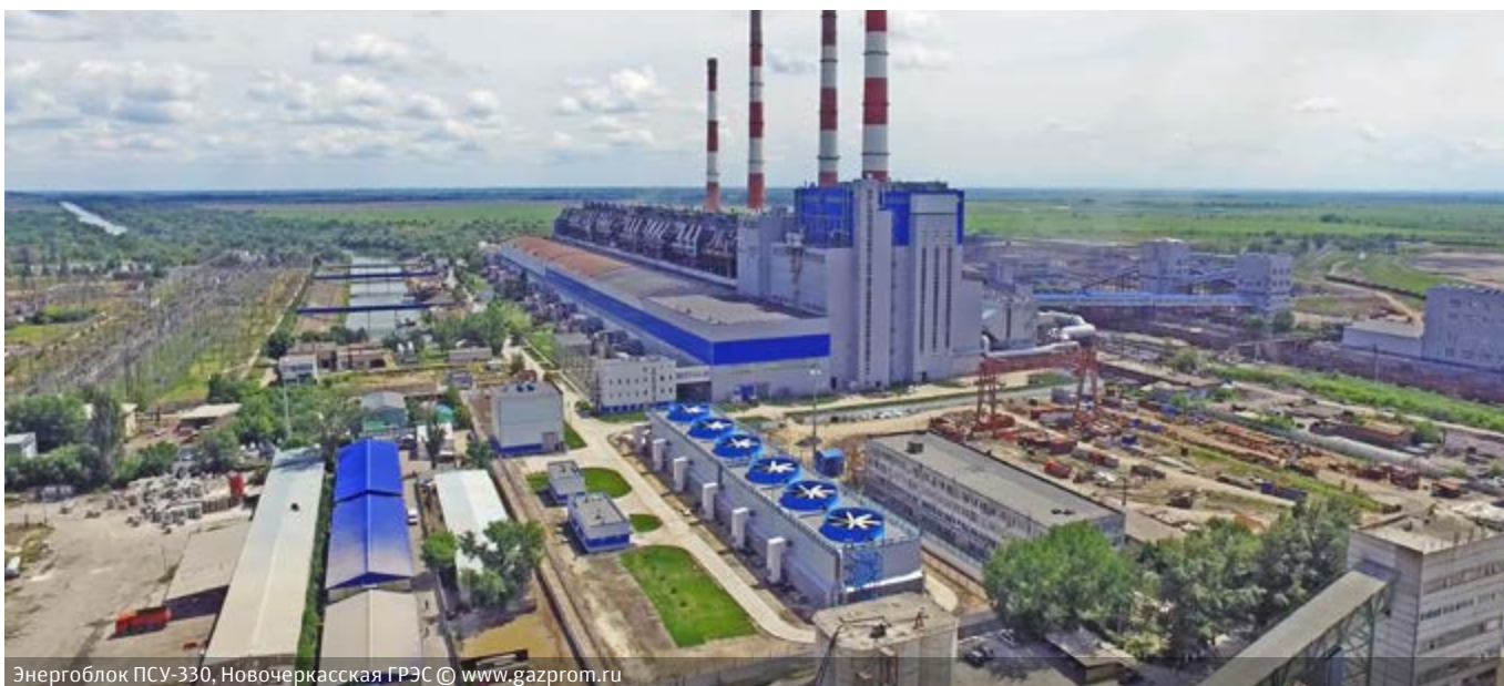
Энергоблок ПСУ-330, Новочеркасская ГРЭС © www.gazprom.ru
