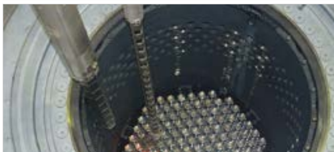
Загрузка ядерного топлива в реактор энергоблока №3 Ростовской АЭС
