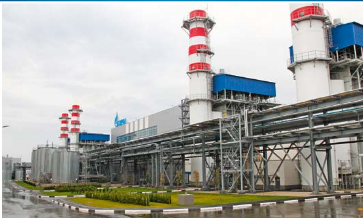
Национальный мегапроект «Сочи 2014». Адлерская ТЭС – самый современный объект энергогенерации г. Сочи. Фото © www.gazprom.ru
