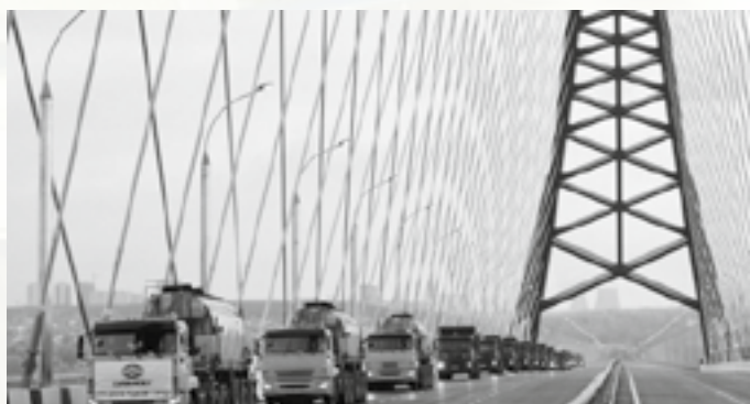
8 октября 2014 г. в Новосибирске открыт новый мост через Обь © www.nso.ru
