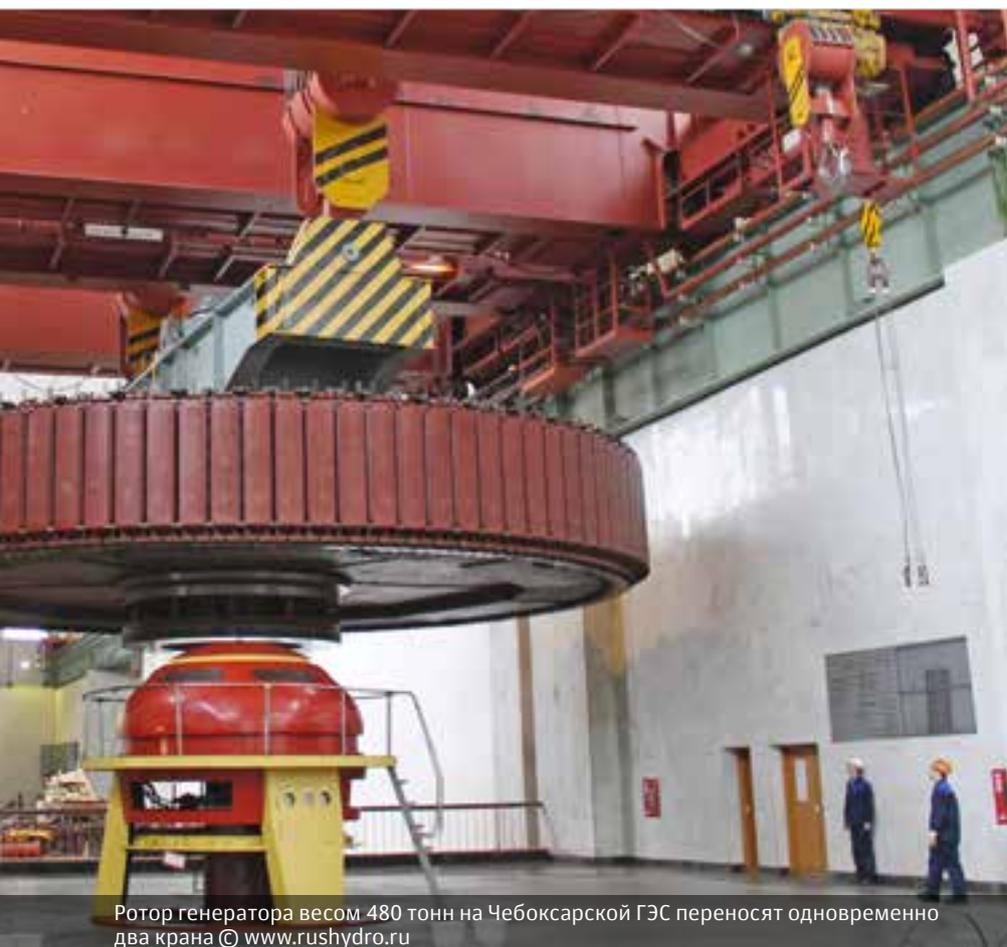
Ротор генератора весом 480 тонн на Чебоксарской ГЭС переносят одновременно два крана © www.rushydro.ru
