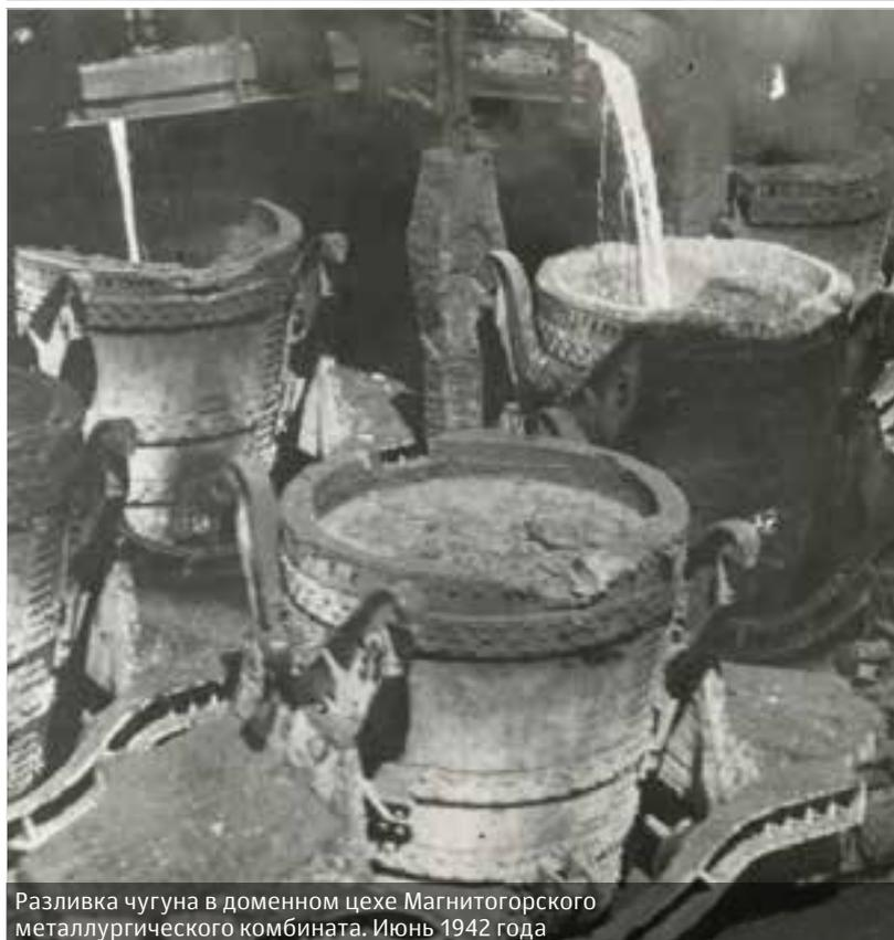
Разливка чугуна в доменном цехе Магнитогорского металлургического комбината. Июнь 1942 года
