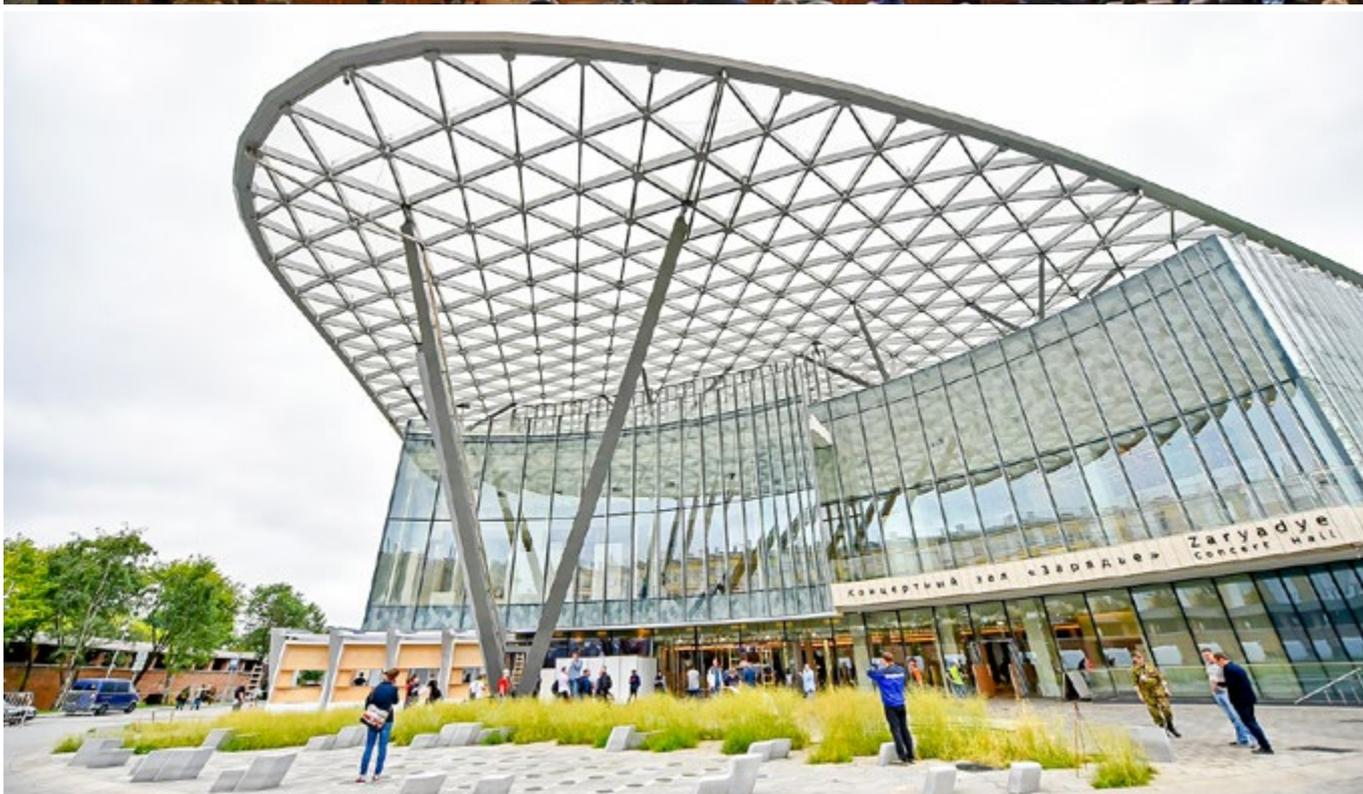
и стеклянных треугольников составляет 8,7 тыс. кв. м. «Стеклянная кора» с помощью солнечных батарей создает микроклимат с повышенной в сравнении с уличной температурой. Основной фасад, выходящий на площадь перед залом, выполнен из стекла. В боковой фасад из натурального камня встроен огромный медиаэкран в форме трапеции.
