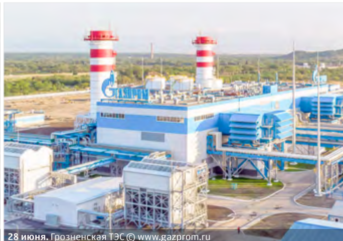
28 июня. Грозненская ТЭС © www.gazprom.ru
