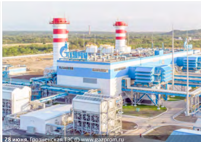
28 июня. Грозненская ТЭС © www.gazprom.ru
