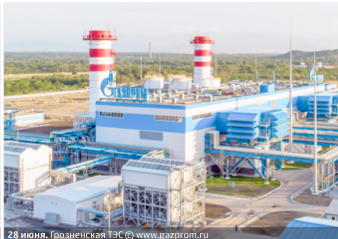
28 июня. Грозненская ТЭС © www.gazprom.ru
