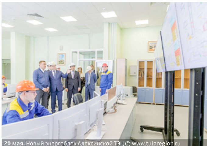
20 мая. Новый энергоблок Алексинской ТЭЦ © www.tula-region.ru
