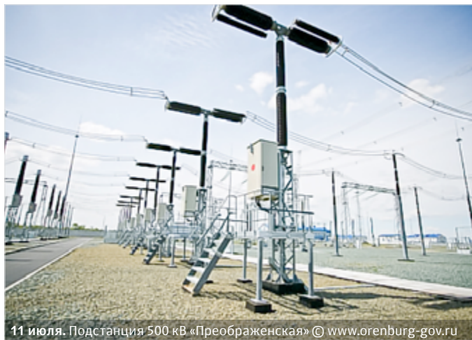
11 июля. Подстанция 500 кВ «Преображенская» © www.orenburg-gov.ru
