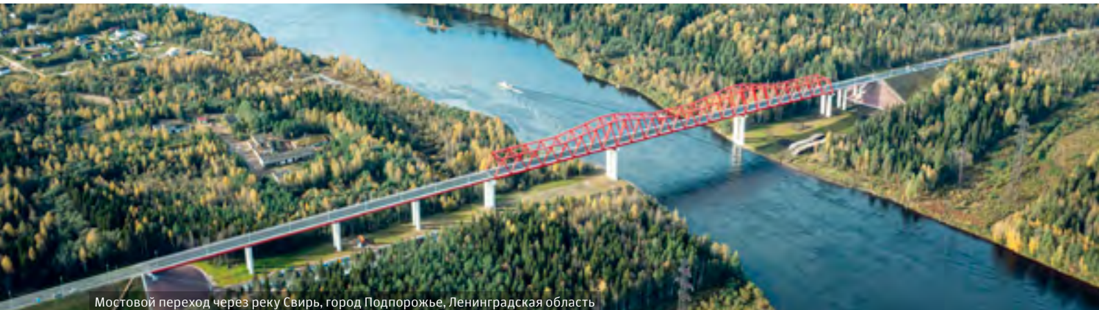
Мостовой переход через реку Свирь, город Подпорожье, Ленинградская область
