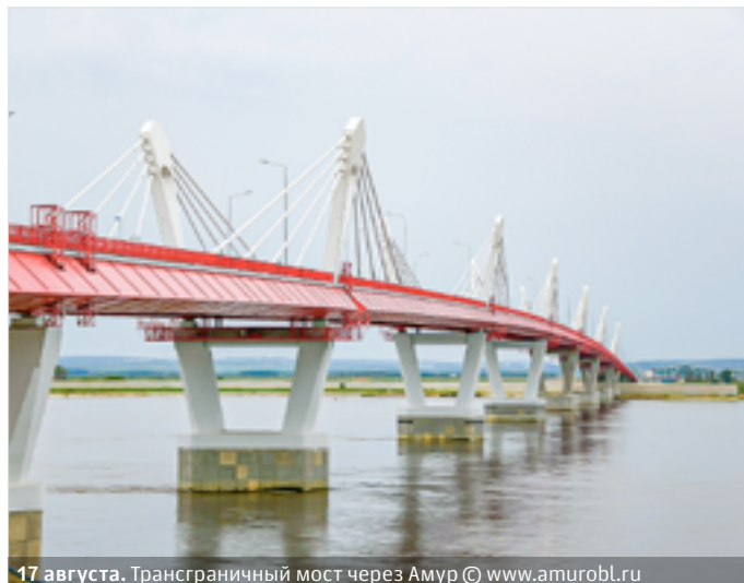
17 августа. Трансграничный мост через Амур © www.amurobl.ru
