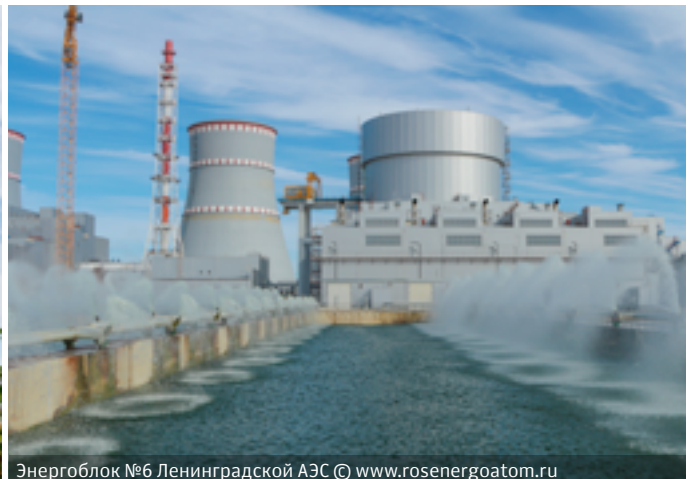
Энергоблок №6 Ленинградской АЭС © www.rosenergoatom.ru
