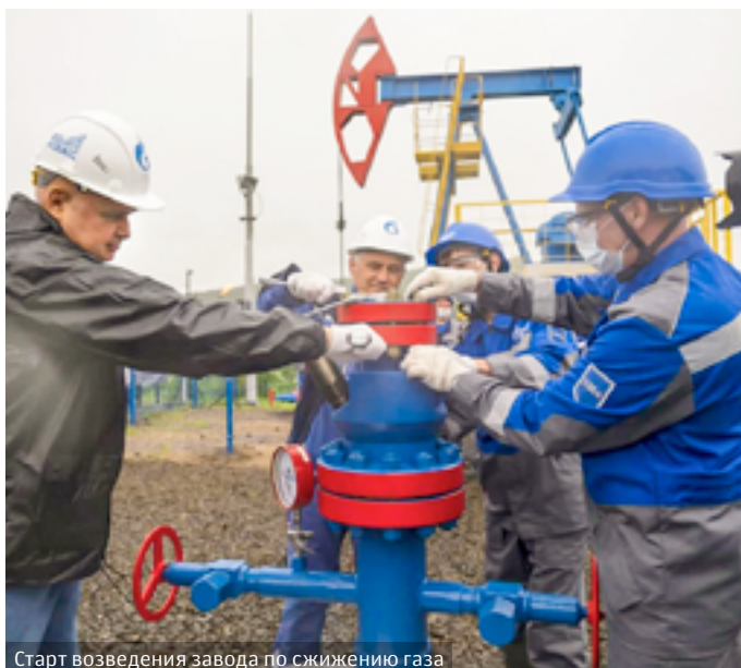
Старт возведения завода по сжижению газа
