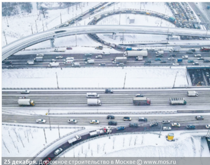
25 декабря. Дорожное строительство в Москве © www.mos.ru
