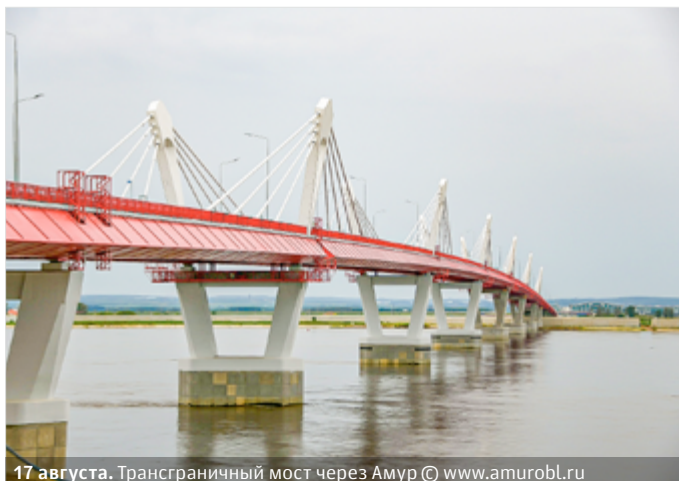
17 августа. Трансграничный мост через Амур © www.amurobl.ru
