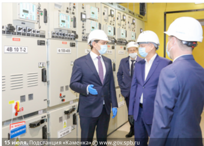
15 июля. Подстанция «Каменка» © www.gov.spb.ru
