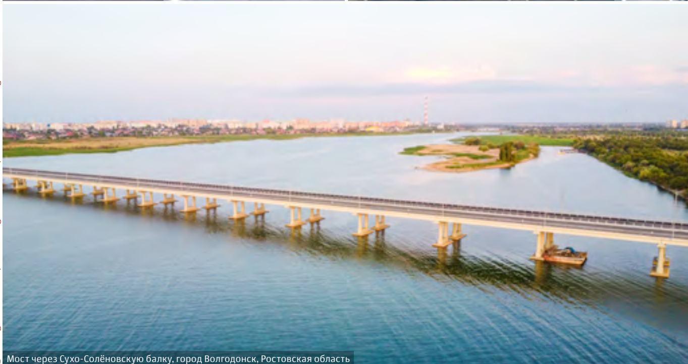
Мост через Сухо-Солёновскую балку, город Волгодонск, Ростовская область
